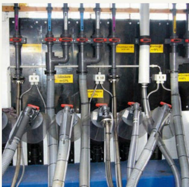
**Soluzioni di riempimento serbatoi affidabili per il trattamento delle acque** Il sistema di tubazioni in PVC-U ad elevata resistenza chimica installato nella struttura superiore del serbatoio e dotato di modalità di riempimento a lotti assicura un processo rapido, accurato e sicuro. Una soluzione che si rivela vantaggiosa in termini di qualità, produttività e costi di manutenzione.
